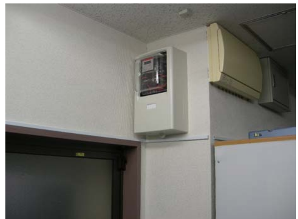
1 階製造現場用に別途電気メータを設置し 製造増減による消費電力を把握
